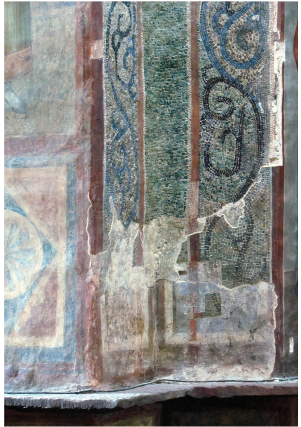
Іл. 12. Північно-західний підкупольний стовп з мозаїками, які переривають залишки раніше виконаної фрески
