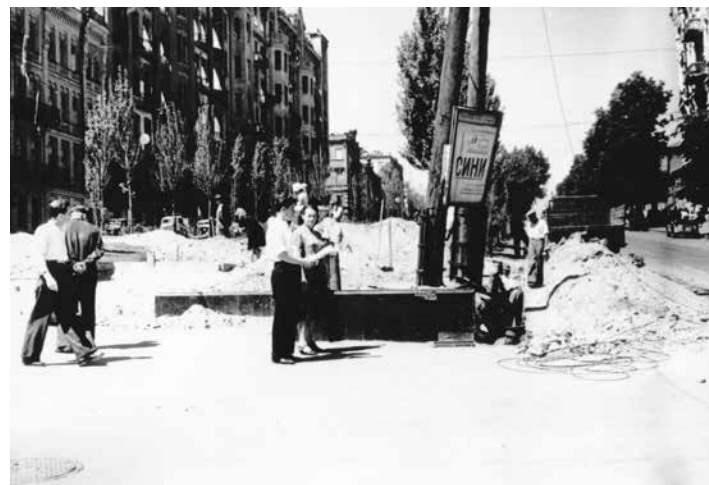
Будівництво пам'ятника Леніну. 1946. З колекції видавництва «Варто»
